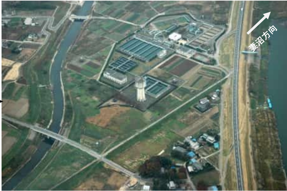
高林給水塔 太田市高林の工業用給水塔。刀水橋の北西約 1km
