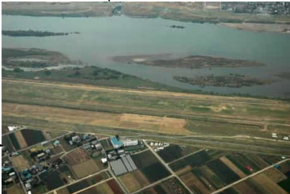
めぬま 妻沼訓練所の格納庫棟
