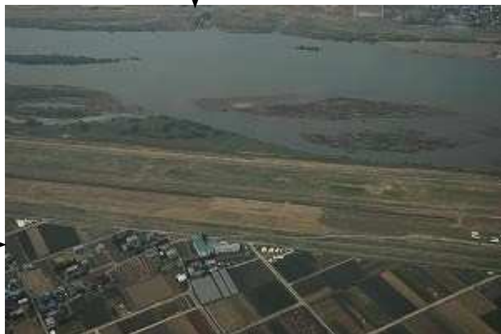
① めぬま 妻沼訓練所の格納庫棟
