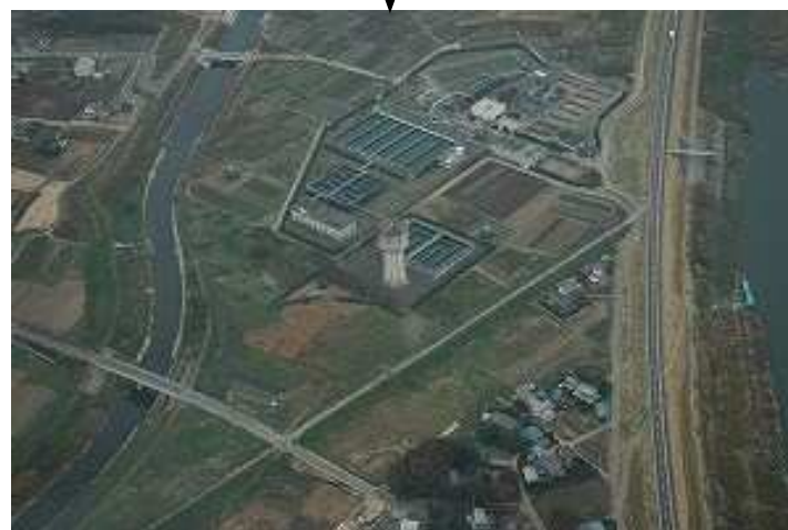
② 高林給水塔 太田市高林の工業用給水塔 刀水橋の北西約 1km
